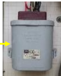
分電盤に設置された低圧コンデンサー
