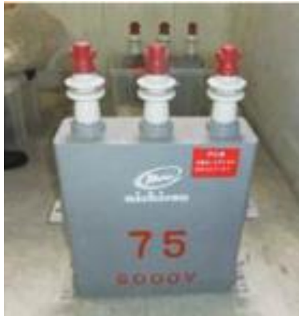
電力用コンデンサー
