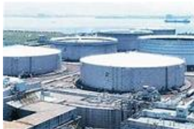
石油貯蔵タンク
